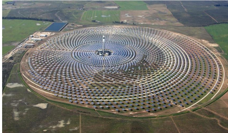
Figura 2. Gemasolar, planta CSP de torre de potencia en Sevilla, España.
