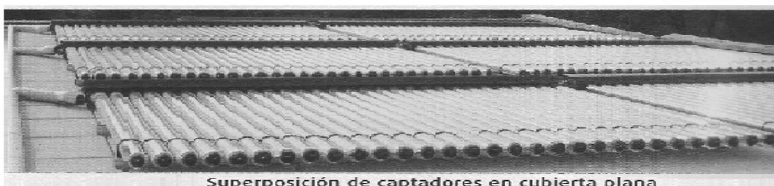
Superposición de captadores en cubierta plana
