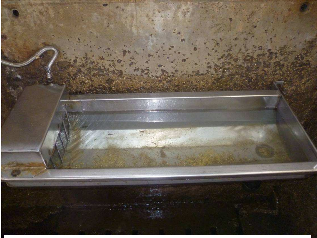
Imagen 9: Punto de agua, bebedero, en correcto funcionamiento y parcialmente sucio
