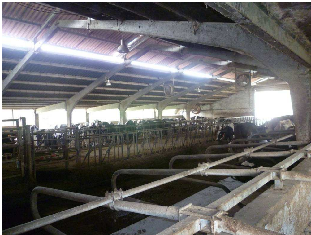
Imagen 3: Nave equipada con ventiladores
