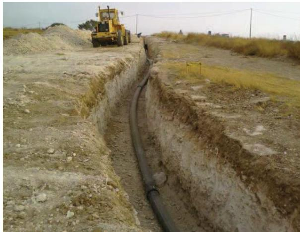
*Fotografía 8.1. Soterramiento de un tubo de riego*
