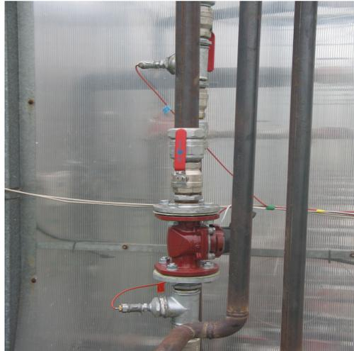
**Figura 23** Sondas de temperatura para el cálculo del gasto energético. Foto cedida por Neiker.
