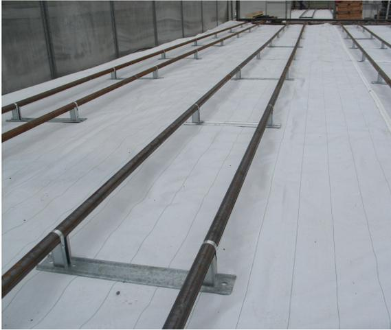
**Figura 9** Monorraíles de calefacción del aire calentados por agua a 80°C. Foto cedida por Neiker.
