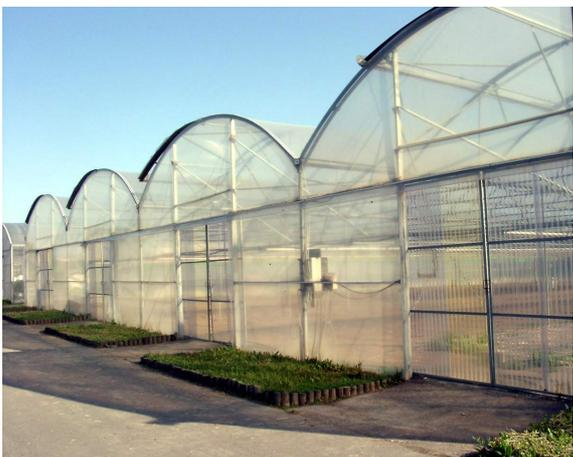
**Figura 7** Invernaderos multicapilla de placa rígida.
