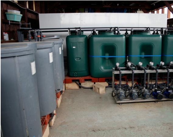
**Figura 13** Sistema de fertirrigación automatizado, tanques de fertilizado con soluciones nutritivas. Foto cedida por Neiker.
