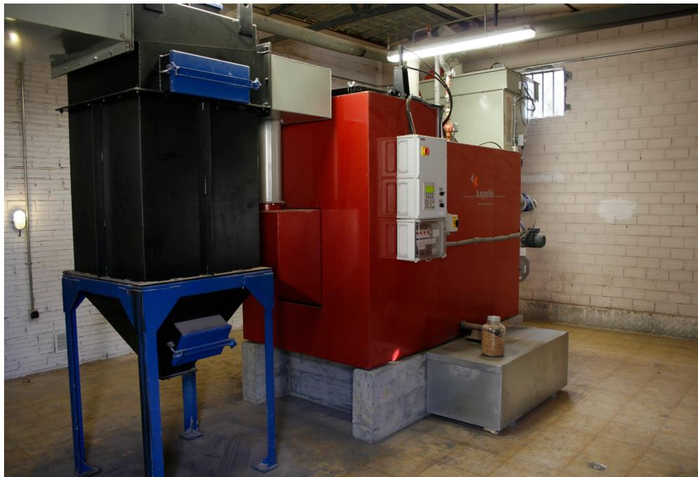
**Figura 11** Caldera de biomasa Osby P500 de 450kW de potencia, funcionamiento con pellets de serrín prensado. Foto cedida por Neiker.
