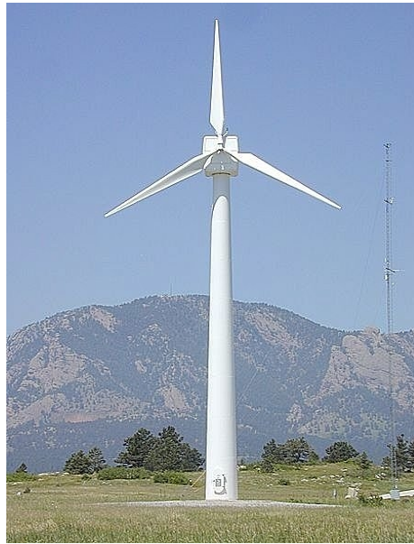
Aerogenerador sobre torre tubular de acero
