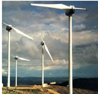
Aerogeneradores monopala
