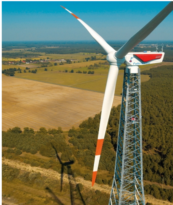
Aerogenerador de Fuhrlander 2,5MW sobre torre de celosía
