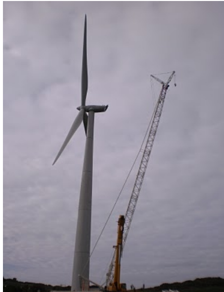
Molino Clotilde, situado en Tafalla, su torre es de hormigón.
