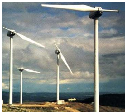
Imagen 2.12: Hélice monopala. Fuente: Energía eólica, Pedro Fernández Diez
