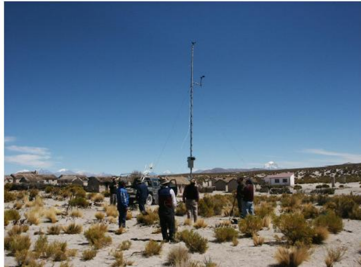
Imagen 3.4: Instalación de anemómetros en Iruni. Fuente: CINER
