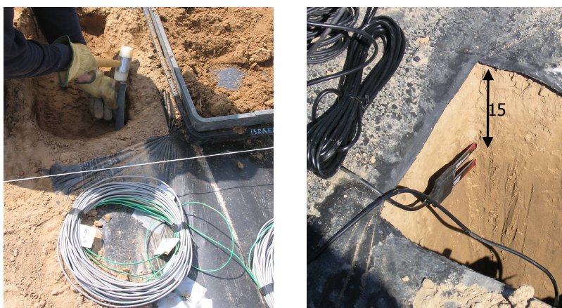
Figura 5. Instalación de los sensores Ech 2 o.
