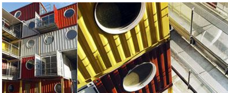
Figura 3. Edificios-contenedores de la zona de los Docklands en Londres
