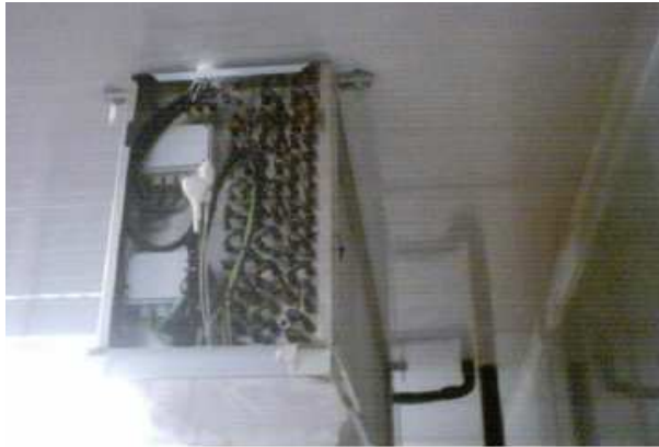
Evaporador con resistencias de desescarche
