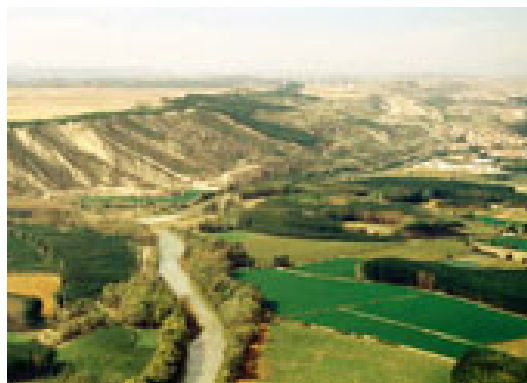
Figura 1. Vista aérea del entorno natural de Marcilla.
