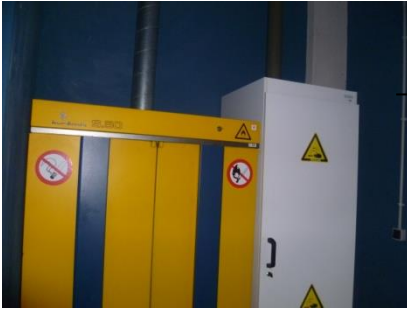
Ilustración 7. Armarios de seguridad para sustancias inflamables.
