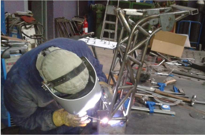
Chasis en el proceso de soldadura
