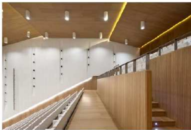
Figura 2.7. Imagen del pasillo superior y del resonador, que separan el palco y la platea.
