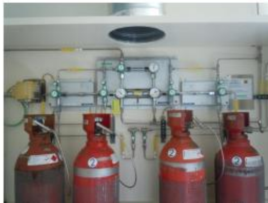
Figura 2.5- Sistema de suministro de hidrógeno[6]
