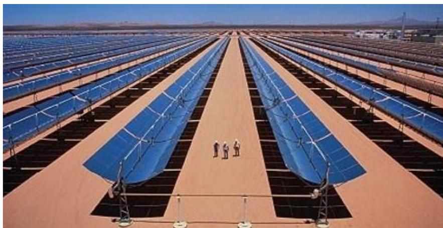
Ilustración 10: Planta de colectores cilindro-parabólicos
