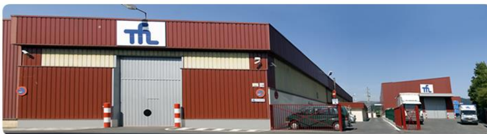
Ilustración 1. Exterior de la empresa Talleres F.Larrinaga
