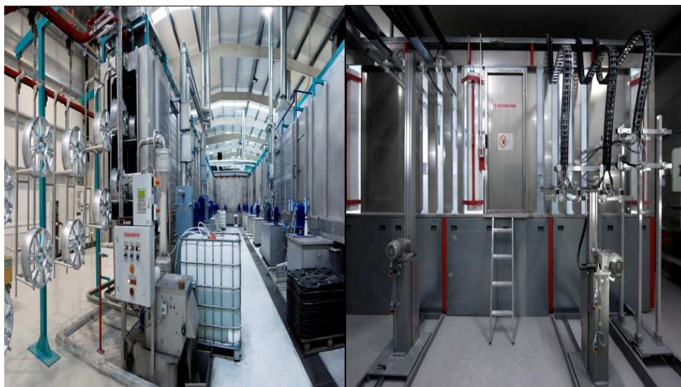
Figura 2.16: Nueva instalación de pintura
