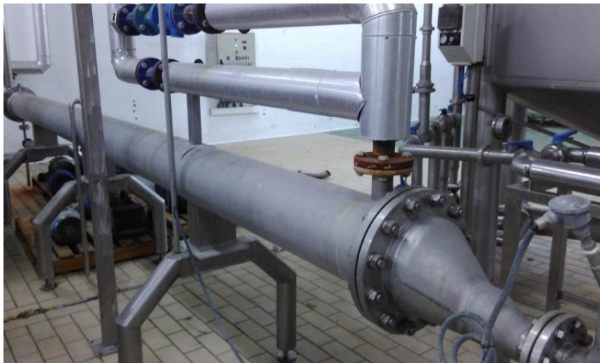
Figura 17: Intercambiador de calor número 4
