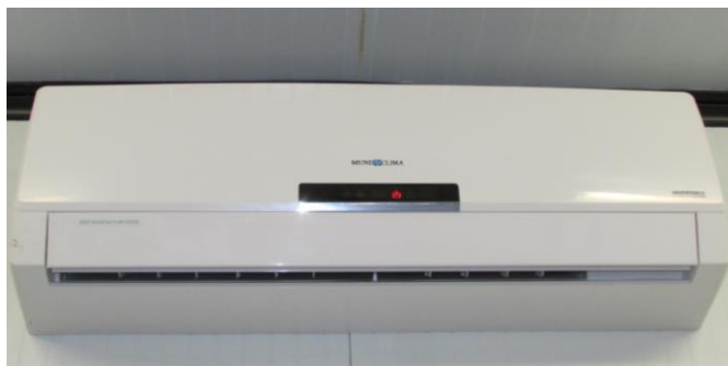
Fig 15. Fancoil sala de control
