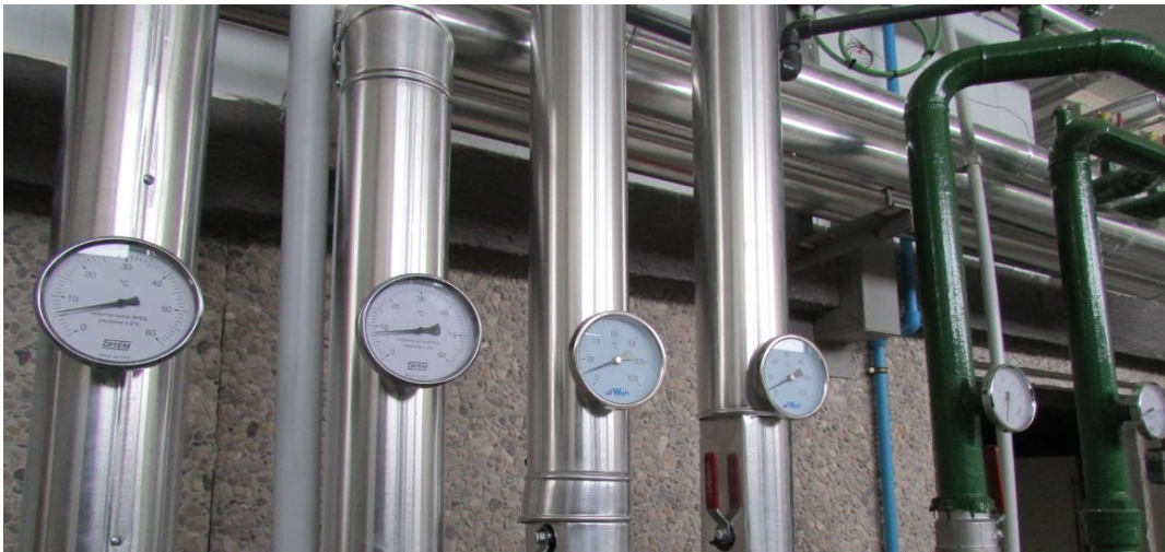
Fig 113. Sensores de temperatura máquina de absorción
