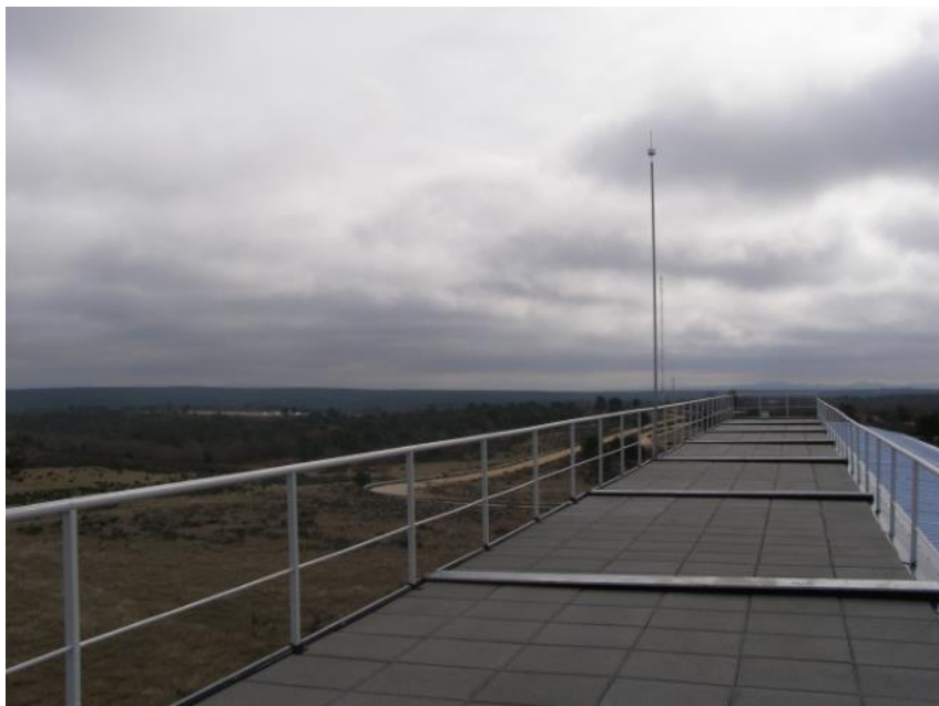
Ilustración 57. Cubierta del edificio LECA. FUENTE: CEDER
