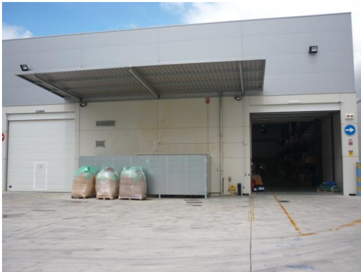
Imagen 9.2 Vista trasera de la nave (previa a la nave de ampliación)
