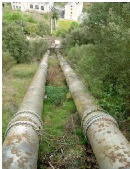
Figura 31. Bajada de las tuberías forzadas desde la cámara de carga hasta la central.
