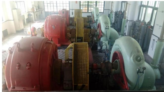
Figura 35. Visión en conjunto de los tres grupos turbina-alternador.
