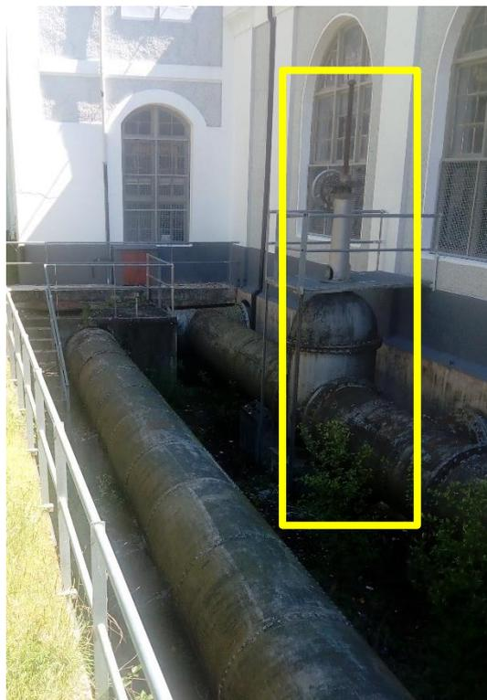
Figura 33. Anillo de unión de las tuberías y válvula de partición.
