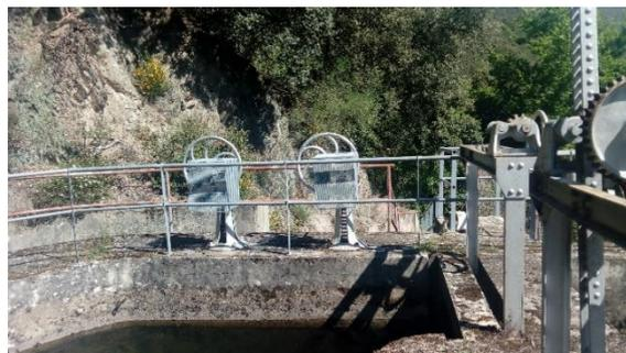
Figura 29. Compuertas del desagüe de fondo.
