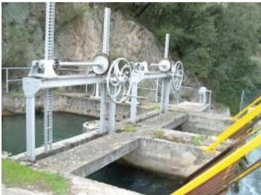
Figura 28. Compuertas para las tuberías forzadas y limpiarejas de la cámara de carga.
