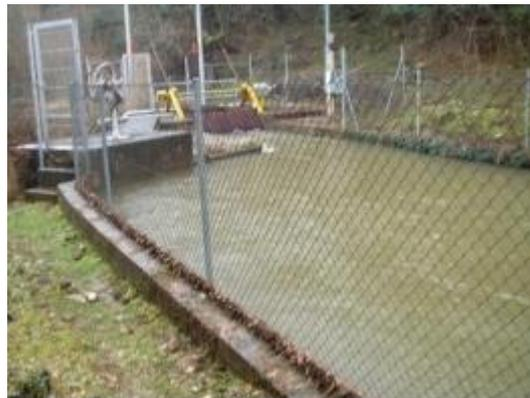
Figura 26. Salida del desagüe de fondo al canal con limpia rejillas.
