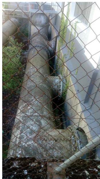
Figura 32. Derivaciones de la tubería a la entrada de la central.
