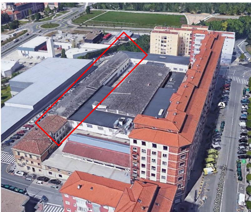
Ilustración 4. Tejado del edificio de Monasterio de Irache
