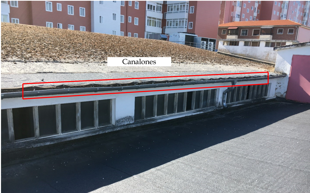
Ilustración 9. Tejado sobre parking de conservación urbana
