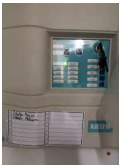
Ilustración 38 Central de alarma
