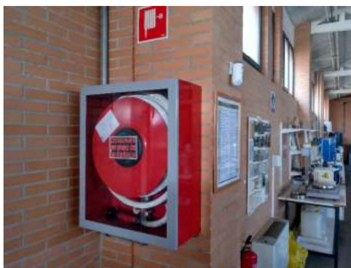
Ilustración 32 BIEs laboratorio
