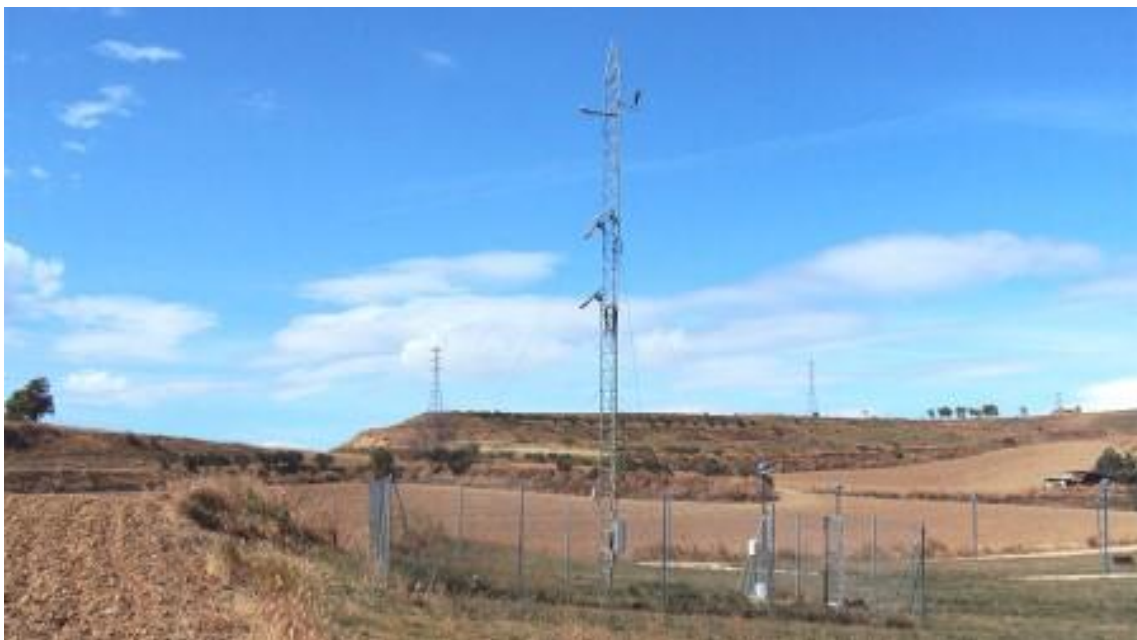
Imagen 1. Estación automática de Tafalla (GN)
