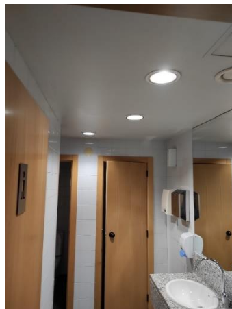
Ilustración 14: Iluminación aseo masculino 3ª Planta. Bombillas de 10 y 15 W
