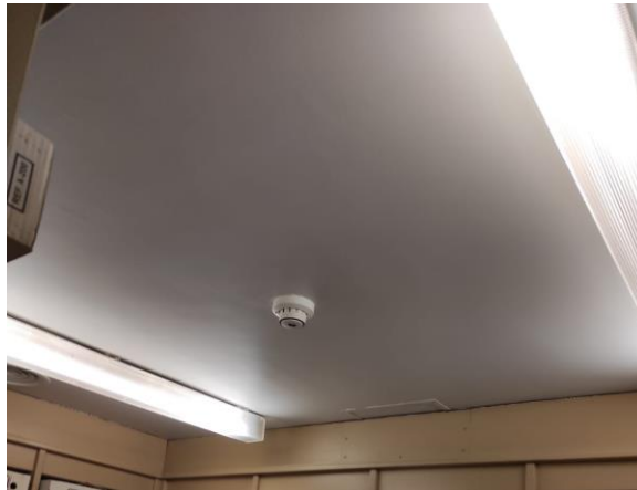
Ilustración 9: Luminaria de 2 tubos de 58 W. Archivo 3.
