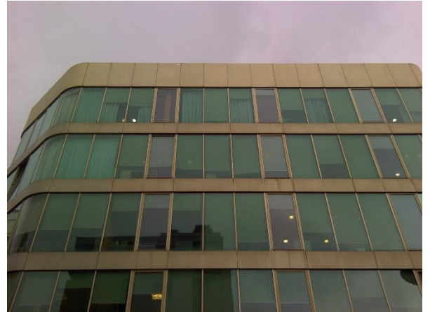
Ilustración 26: Ventanas fachada sureste
