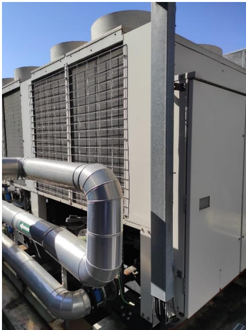
Ilustración 21: Enfriadora HITACHI Samurái RC2UE 120 AG2
