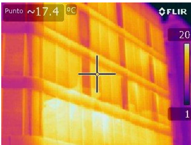
Ilustración 25: Termografía fachada sureste
