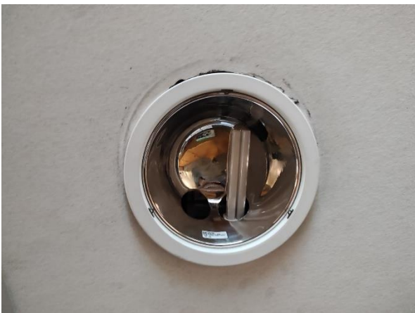
Ilustración 11: Luminaria lámpara fluorescente compacta 26 W
