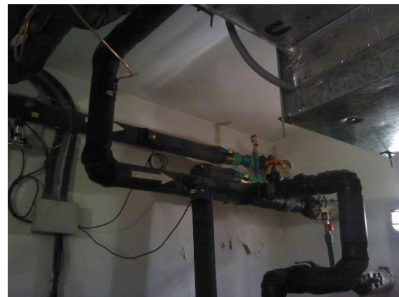
Ilustración 43: Sistemas de distribución de climatización
