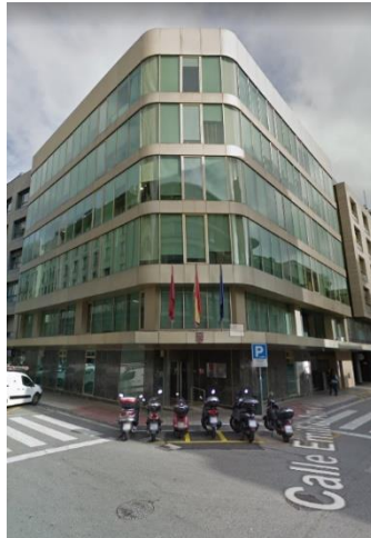
Ilustración 1: Edificio Administración Local. Fte: Google Maps.
