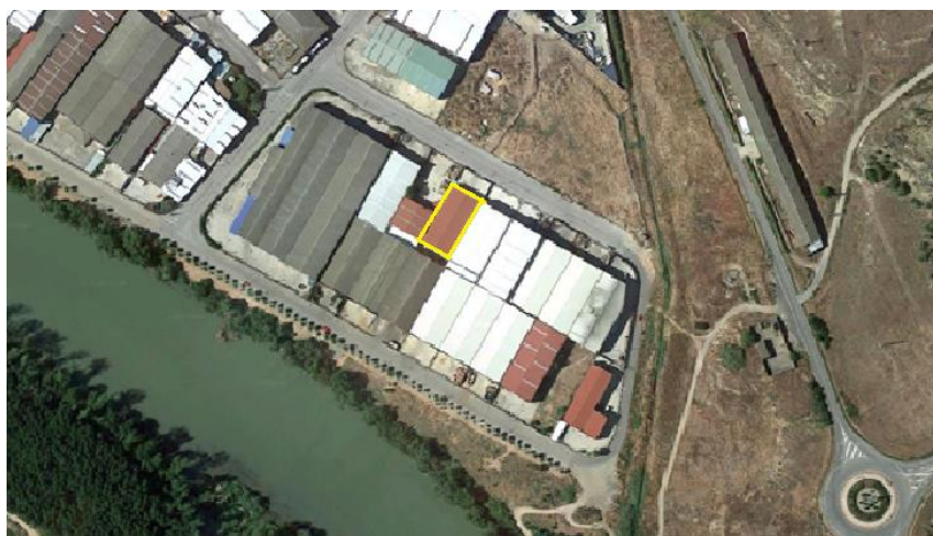
Figura 1. Ortofoto del polígono industrial “El Ramal” de Lodosa [3]
