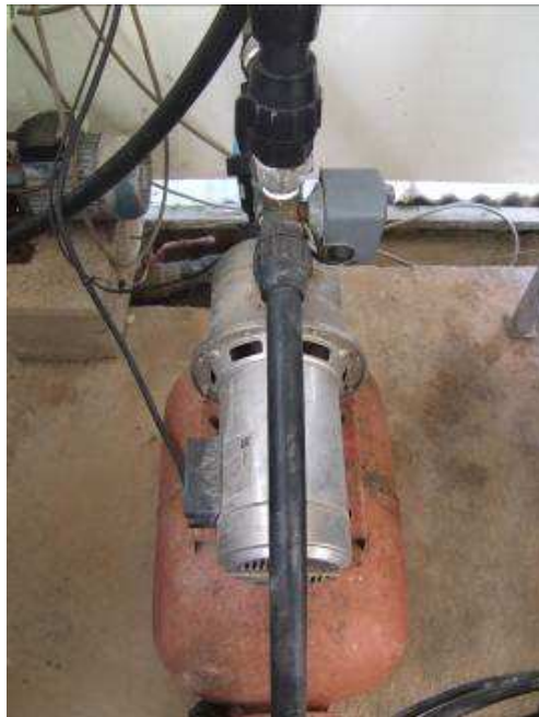
Figura 5.20. Grupo de presión del equipo de riego
