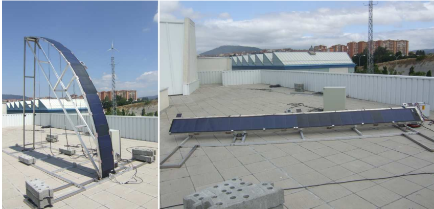
Figura 8.9. Panel colocado sobre estructura curva y plana.
