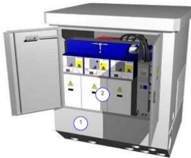
Figura 1.1: Elementos principales del Centro de Transformación miniBLOK
