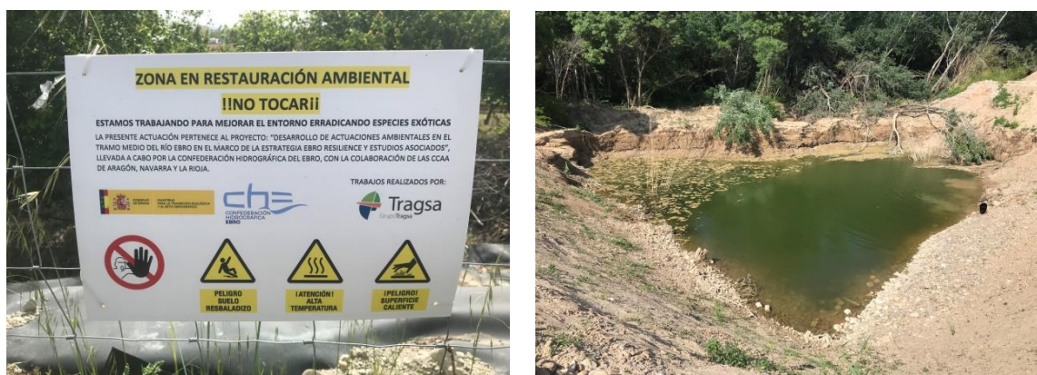
Figura 16: Ejemplo de la restauración fluvial que se está realizando en el tramo de estudio. (Fuente: autora de este trabajo)
