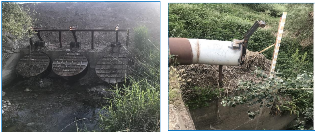
Figura 1.- Estructuras hidráulicas de desagüe. (Fuente: autora de este trabajo)
