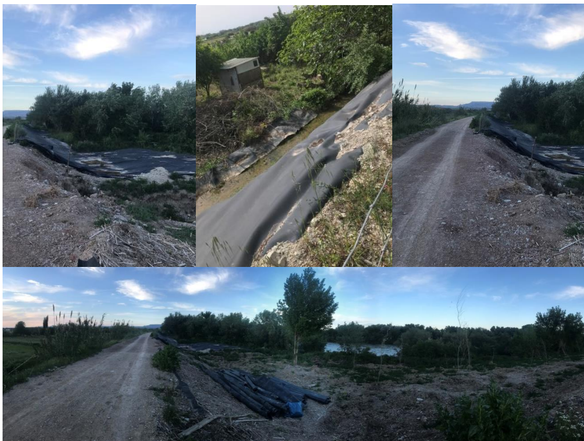
Figura 15: Recubrimiento de plástico en las motas del dique. (Fuente: autora de este trabajo)
