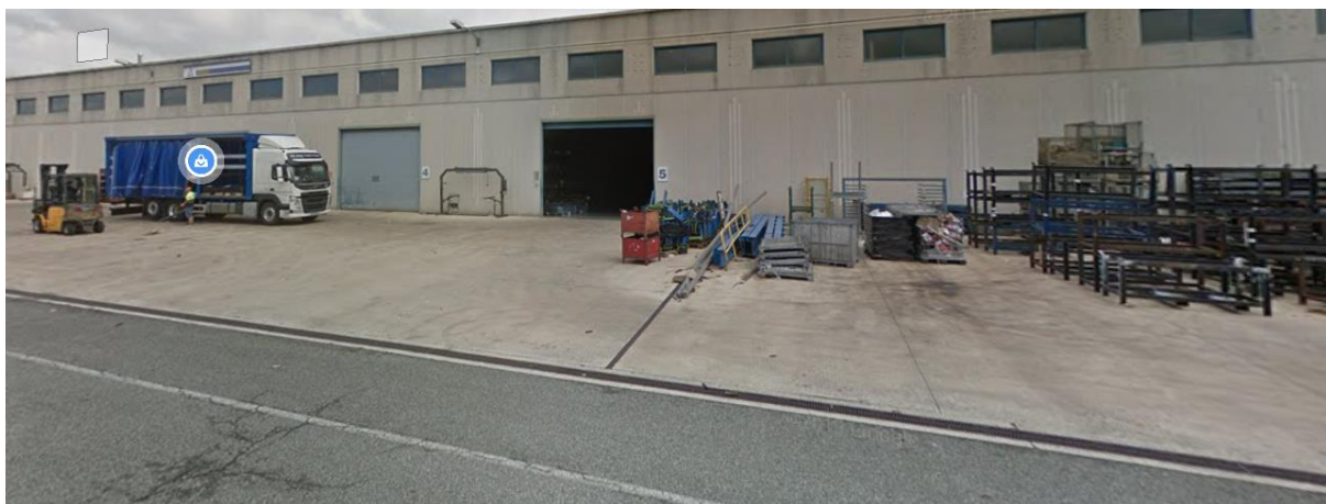
Figuras 3 y 4: Situación fábrica Mecedetol S.A.
