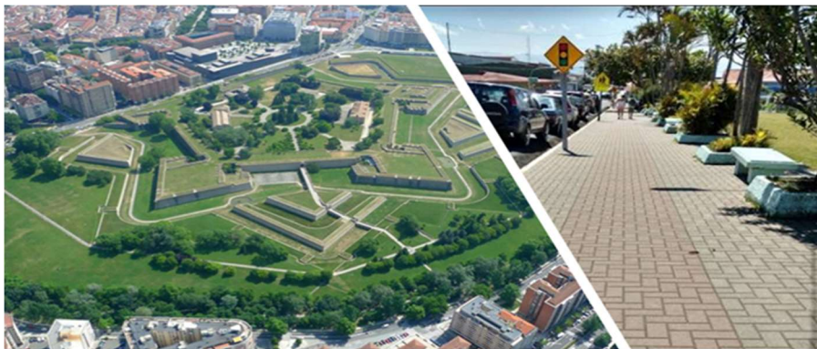
Figura 1.7 Infraestructuras urbanas: Ciudadela de Pamplona, acera
