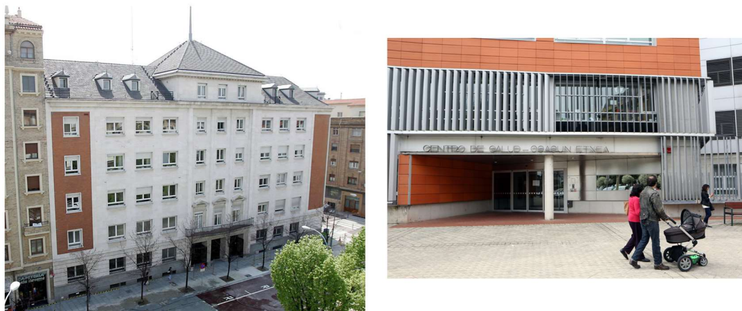
Figura 2.25 Centros sanitarios nivel 2 de Navarra
