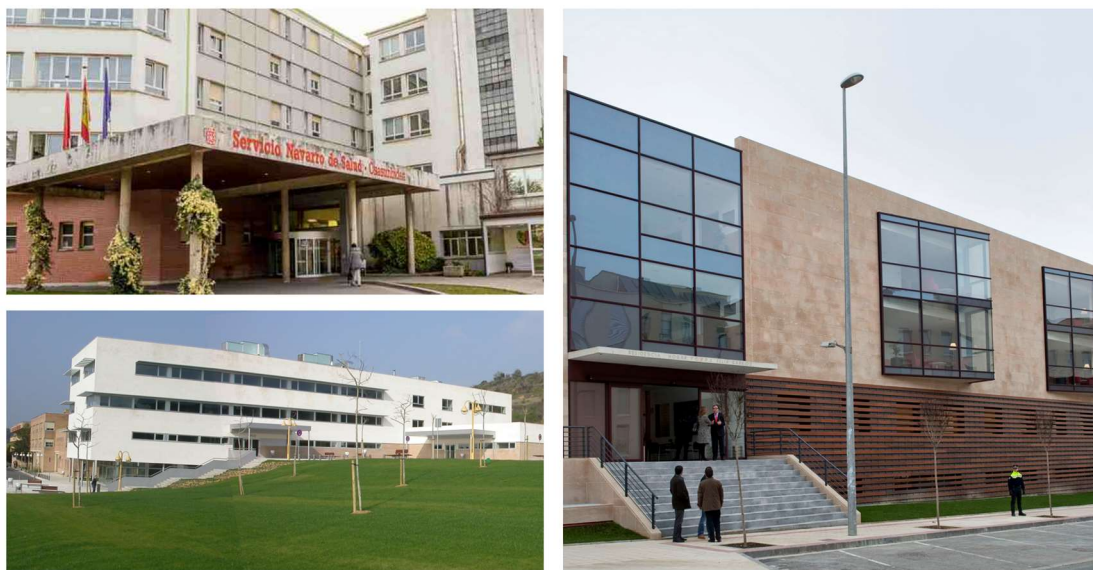
Figura 2.24 Centros sanitarios nivel 1 de Navarra
