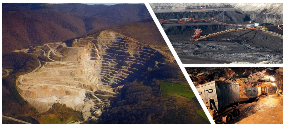
Figura 1.21. Minas y canteras. Ejemplos de infraestructuras mineras
