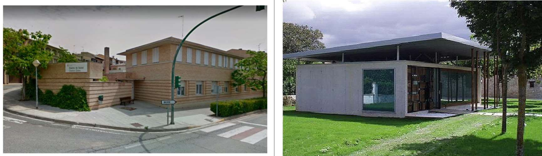
Figura 2.26 Centros sanitarios nivel 3 de Navarra.
