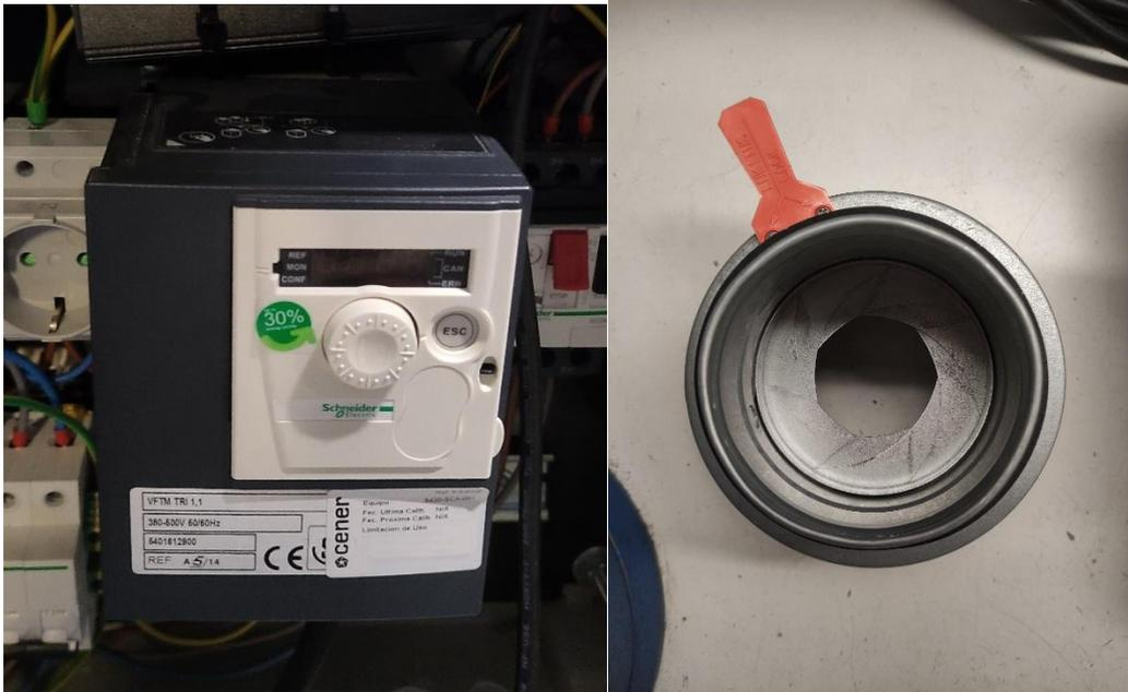
Figura 3. 21 Variador de frecuencia (izq) y ojo de pez (der) para el control del flujo de aire
