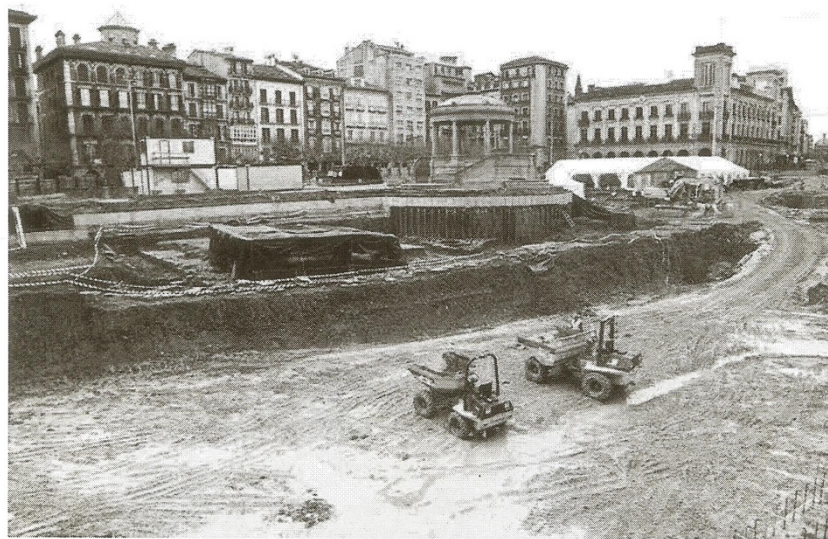
Imagen n°2. Vista de las obras de aparcamiento de la plaza del Castillo (L. F. Arroyabe, 2001) 2
