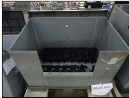
Imagen 2.6.2.4: GLT protección baterías
