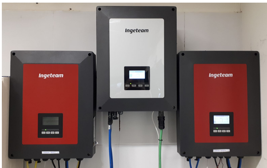
Figura 6.5 Inversores de potencia microrred (de izquierda a derecha: Bat. 1, FV, Bat 2)
