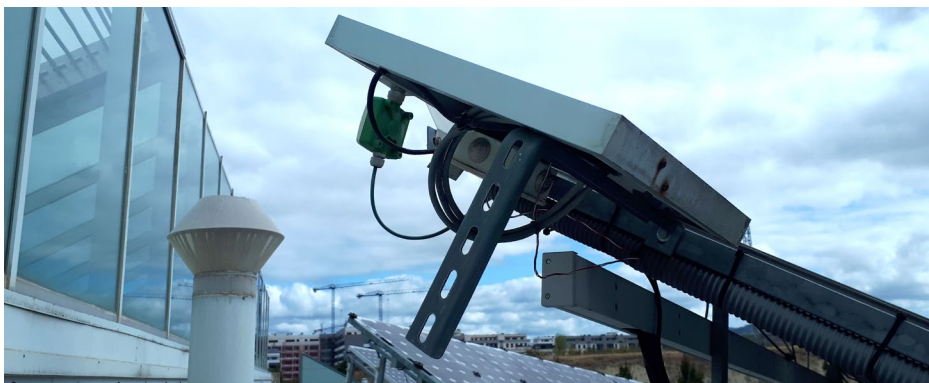
Figura 6.7 Instalación sensores variables meteorológicas microrred
