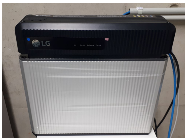
Figura 6.6 Batería LG Chem RESU3.3
