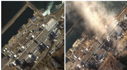
Figura 24.7: Vista aérea de la central de Fukushima (Japón) antes y después del accidente del año 2011. Imagen de Vimeo (jimbonumber9).
