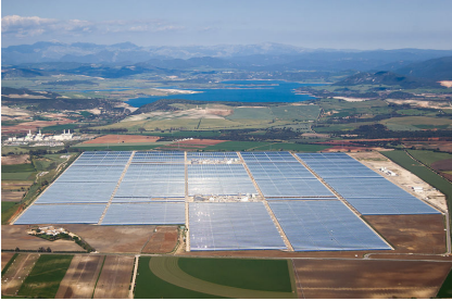
Figura 25.8: Centrales Valle 1 y Valle 2, en Cádiz, formadas por hileras de concentradores solares cilindroparabólicos. Foto de Arvydas Cetyrkovskis.
