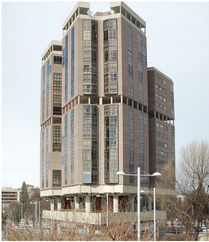
Figura H.4: Edificio Singular, Pamplona.
