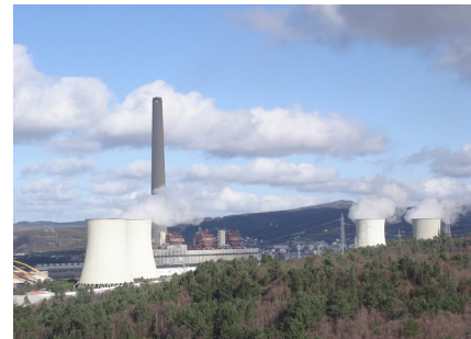
Figura 23.1: Centrales térmicas de carbón de Compostilla II (León) y de Puentes de García Rodríguez, más conocida como de As Pontes (A Coruña). Se trata de las dos centrales con mayor capacidad en España (1341 MW y 1468 MW, respectivamente). Imágenes originales distribuidas mediante Wikipedia bajo licencia Creative Commons Attribution 2.0 Generic y Creative Commons Attribution-Share alike 3.0 (Silvia Alba y PepedoCouto).
