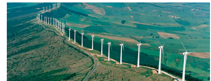
Figura B.3: Parque de El Perdón, en las proximidades de Pamplona (Navarra), formado por 40 máquinas de 500 kW, con un diámetro de 39 m cada una. Fuente: Acciona.
