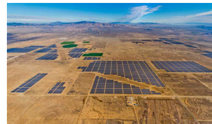
Figura 25.5: Las zonas desérticas ya se usan en la actualidad para instalar grandes plantas fotovoltaicas. Foto extraída de [163].
