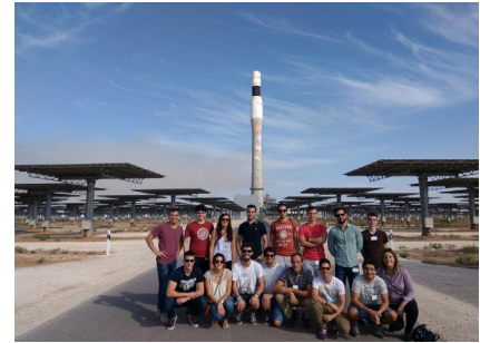
Figura 25.4: Miembros de la asociación de estudiantes Aperia visitando la central termoelectrónica de Gemasolar, en Andalucía, durante una parada de la central por mantenimiento. El exceso de energía térmica producida durante el día en esta central se puede almacenar hasta 15 horas en tanques de sales fundidas, permitiendo un suministro de potencia a la red eléctrica continuo y constante. La central de 17 MW de potencia produce 80 GWh al año. Sus 2650 heliostatos ocupan 200 hectáreas, por lo que la densidad de potencia media por unidad de área es de 5 W/m 2 .
