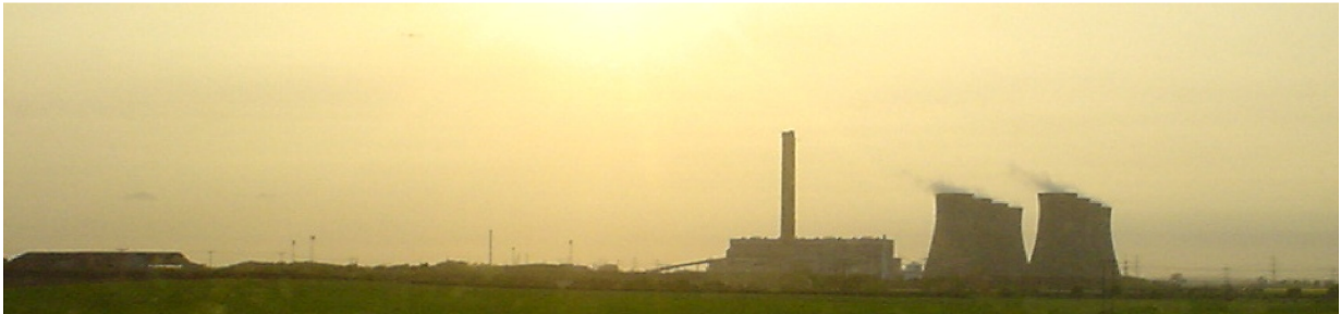
Figura 23.4: Central térmica de carbón.
