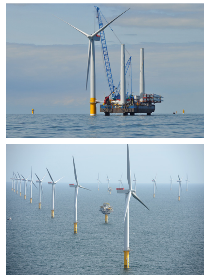
Figura 10.1: En la figura superior se muestra el montaje de un aerogenerador marino en el parque eólico de Greater Gabbard, Inglaterra. En la imagen inferior, el de Sheringham Shoal de 317 MW, Inglaterra. Foto de CHPV.
