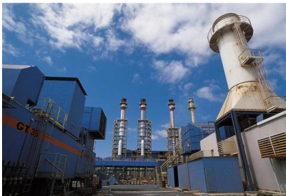
Figura 21.13: Central térmica de ciclo combinado de Fuerteventura, Canarias.
