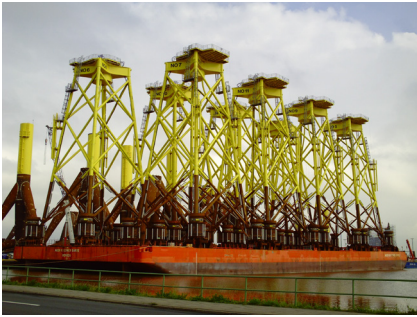
Figura 10.2: Estructuras empleadas para anclar los aerogeneradores al fondo marino.
