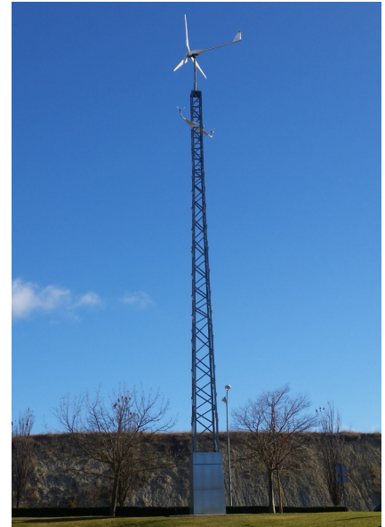
Figura B.8: Aerogenerador de 6 kW situado en el campus de la Universidad Pública de Navarra (UPNA). La energía media generada por esta turbina, situada en un entorno urbano, es de 5 kWh al día. Foto de Javier Samanes.
