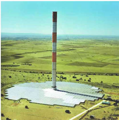
Figura 25.6: Chimenea solar de la planta piloto instalada en Manzanares (1982-1989). Foto de Jumanji Solar.
