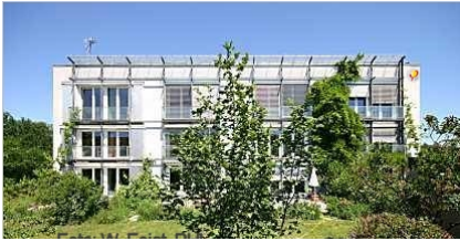
Figura E.7: Primer edificio que se construyó bajo el estándar Passivhaus, situado en la localidad de Darmstadt, Alemania. Foto de W. Feist.
