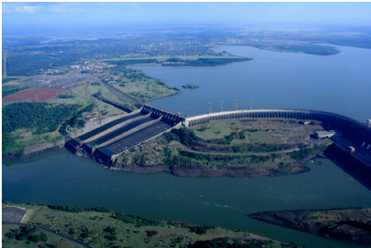
Figura 30.5: Represa de Itaipú en el río Paraná. Prácticamente empatada en generación de energía con la presa de las Tres Gargantas en China, genera unos 100 000 GWh al año. Fuente: International Hydropower Association.
