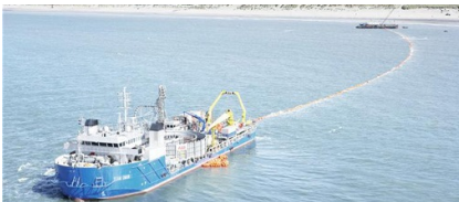
Figura 25.2: Instalación de un cable submarino, como el proyectado en el proyecto NordLink, comenzado en 2015 y que en 2019 conectará Alemania con Noruega mediante una línea submarina de 623 km de longitud que permitirá transmitir una potencia de 1400 MW. El coste total de este proyecto se estima entre 1500 y 2000 millones de euros. Foto: ABB.
