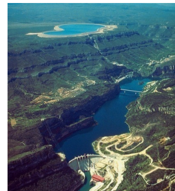
Figura 26.4: Central hidroeléctrica de Cortes-La Muela, en la Comunidad Valenciana. Puede almacenar hasta 35 GWh y su potencia total es de 1,7 GW. Foto de Iberdrola.
