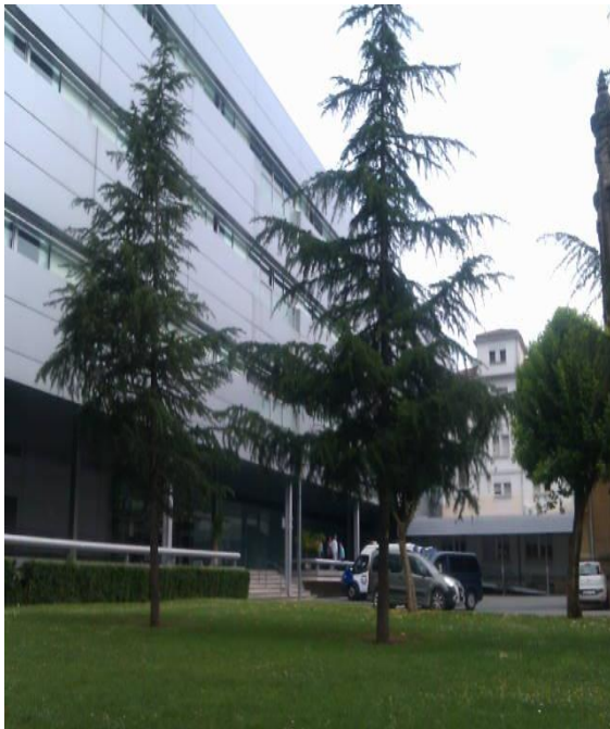
Foto Complejo Hospitalario de Navarra Elaboración propia
