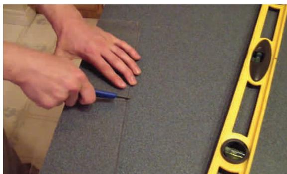
Figura 19.3: Cortado del plástico con cúter
