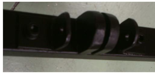
Figura 8.8-Anclaje de los tirantes del amortiguador.
