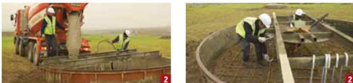
Figura 19. Cimentación de las zapatas
