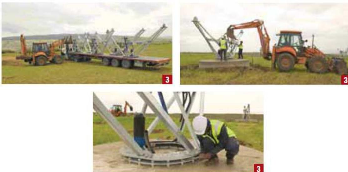
Figura 20. Colocación del soporte del seguidor sobre las zapatas
