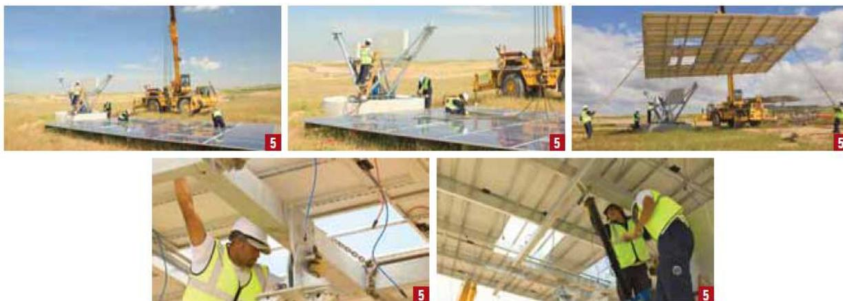
Figura 22. Colocación de los Módulos sobre la estructura
