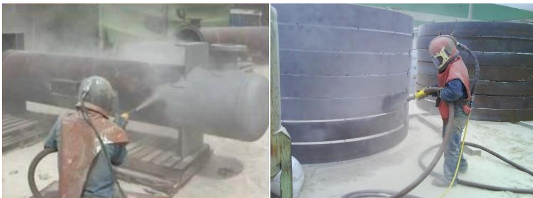
Ilustración 43: Proceso de granallado
