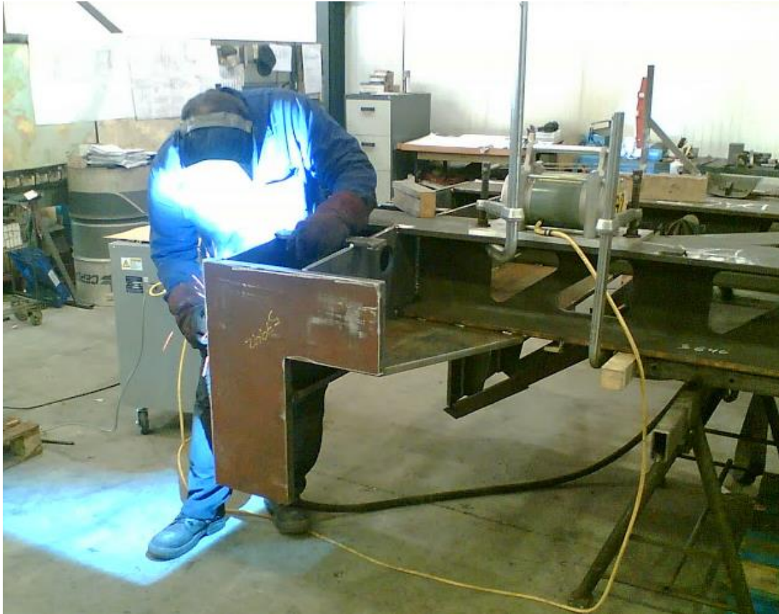
Ilustración 57: Aplicación de vibración durante el proceso de soldadura
