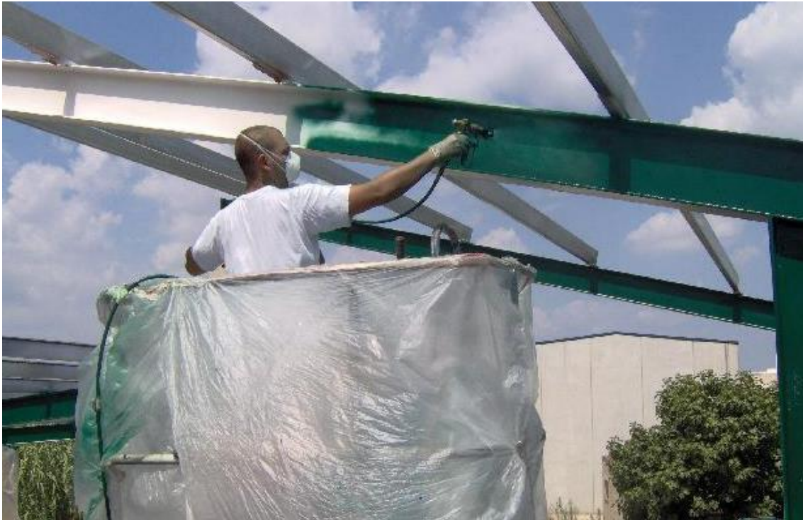
Ilustración 44: Proceso de pintura
