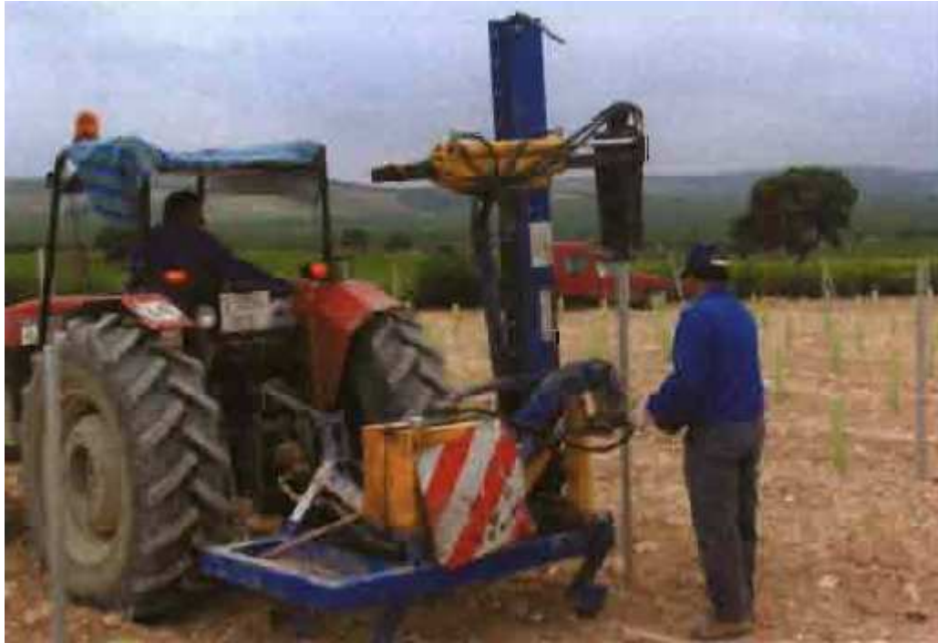
Foto 7: Máquina Plantadora de postes
