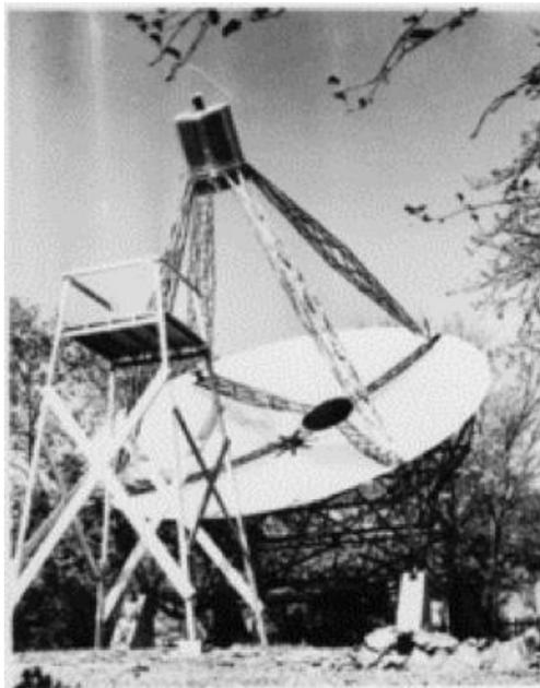
Ilustración 1. Primer radiotelescopio construido por Grote Reber. Fuente: Google imágenes.
