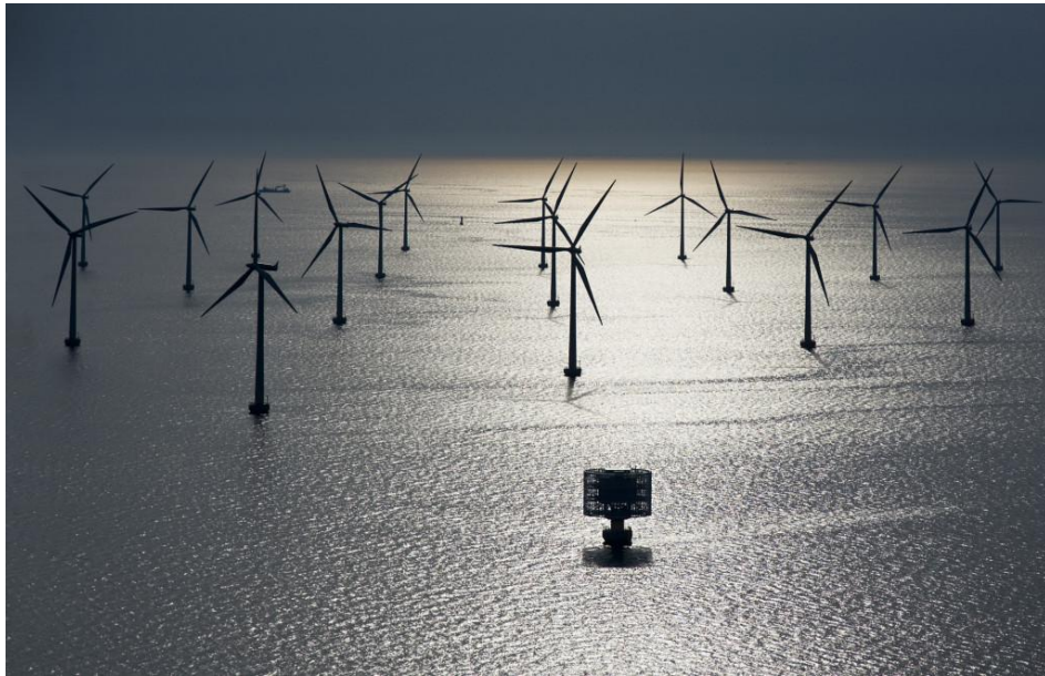
Figura 115. Parque eólico offshore Westermeerwind de SIEMENS en los Países Bajos [16]
