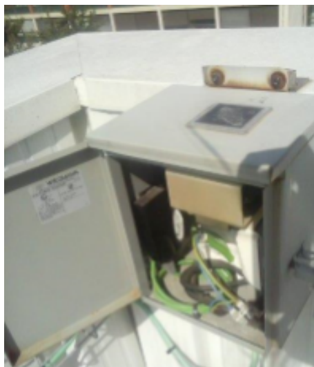
Figura 1. La cámara de meteoros y su cubierta impermeable.
