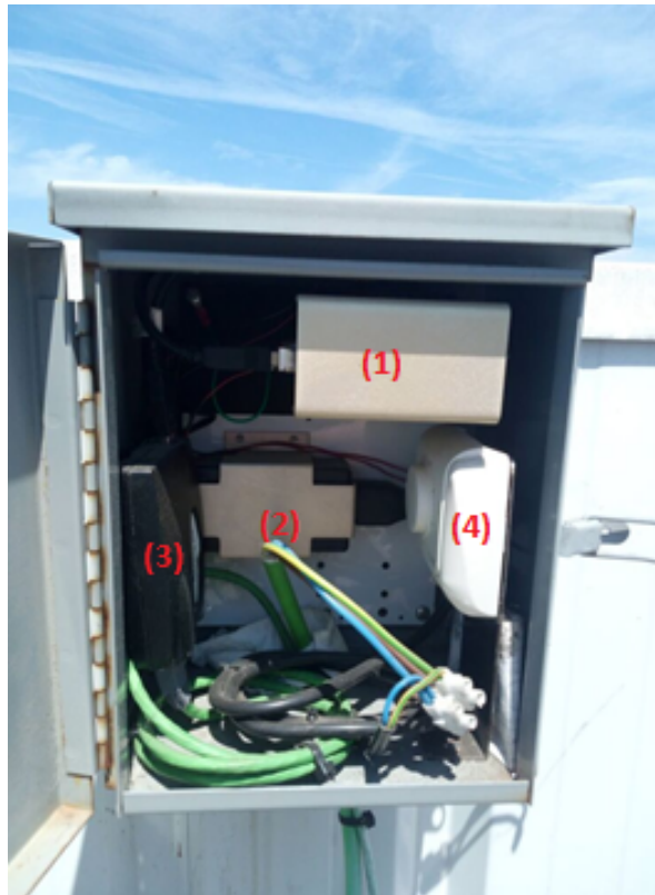
Figura 3. Interior de la cámara de meteoros.
