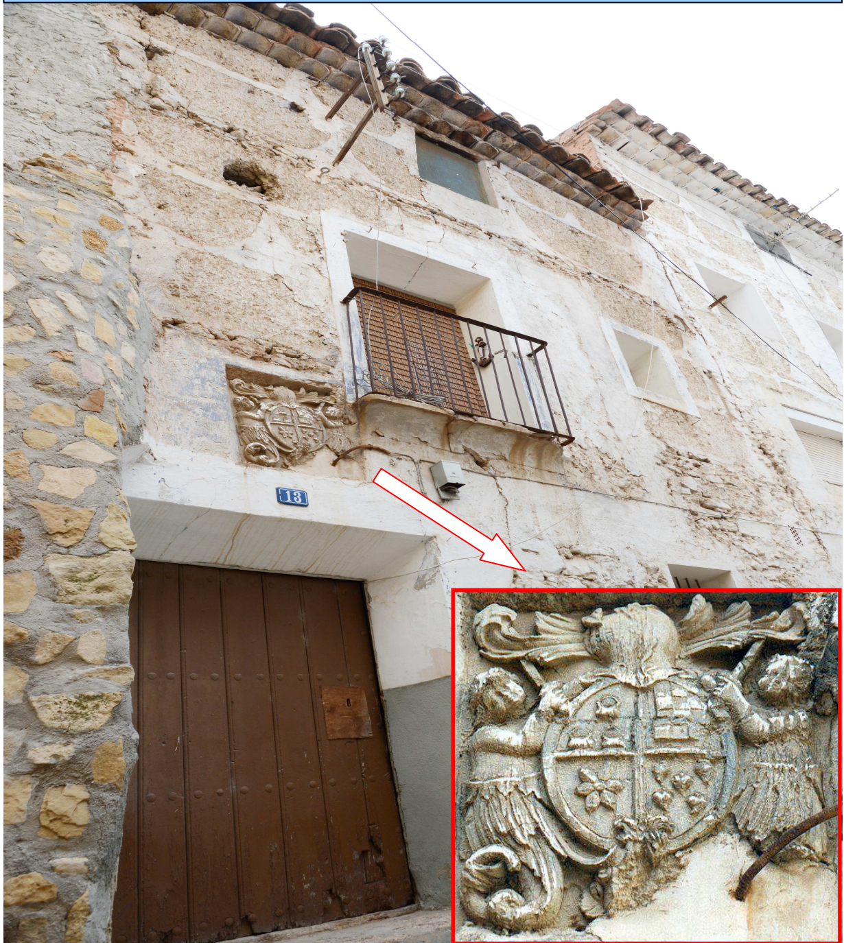
Fig. nº 12: fachada principal con detalle del escudo
