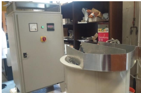
Figura-53. Montaje en su totalidad del circuito necesario para la realización del anodizado.
