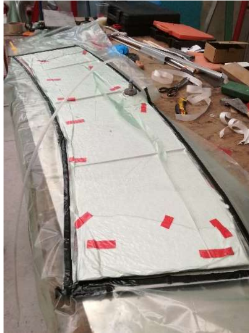
Fig. 36 Aplicando vacío al conjunto
