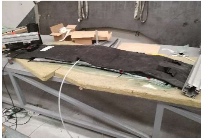
Fig. 39 Aislamiento inferior del conjunto y colocación de la manta
